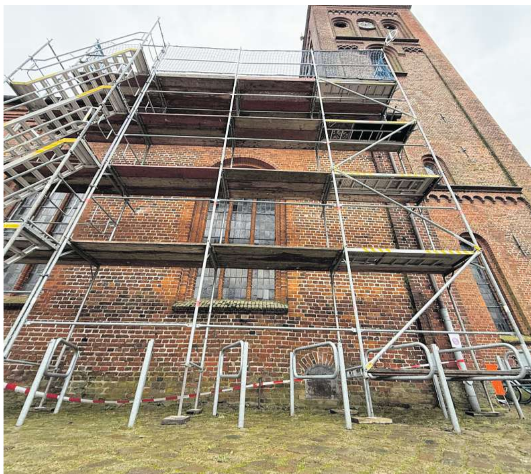
Seit Anfang dieser Woche ist für erste Sicherungsmaßnahmen ein Gerüst an der Nikolaikirche aufgebaut.
