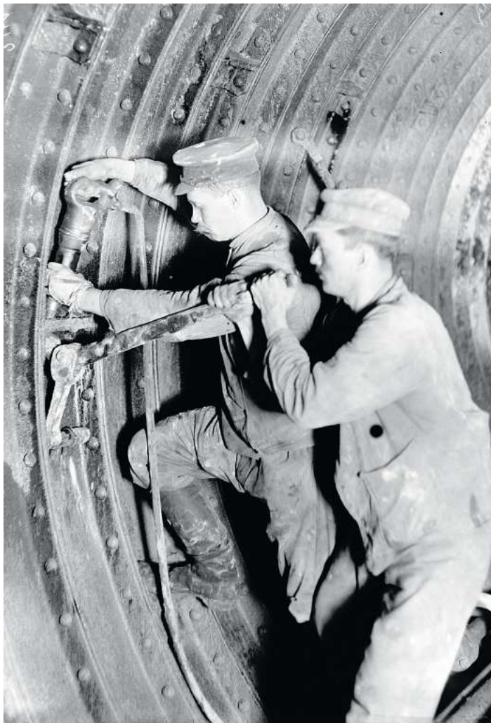
Für die Abwasserleitung von Kiel nach Bülk wurde von 1911 bis 1913 ein Tunnel unter dem Nord-Ostsee-Kanal gebohrt. Arbeiter nieten Tunnelstützen zusammen. FOTO: STADTARCHIV KIEL/FOTOGRAF UNBEKANNT
