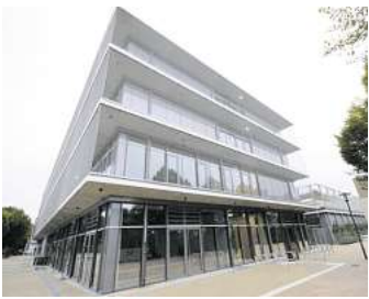
Auch die umlaufenden Balkons in den oberen drei Etagen sind mit transparentem Edelstahlnetz gesichert. Das Netz dient auch als Rankhilfe für die später begrünte Fassade. FOTO: JAN KÖSTER
