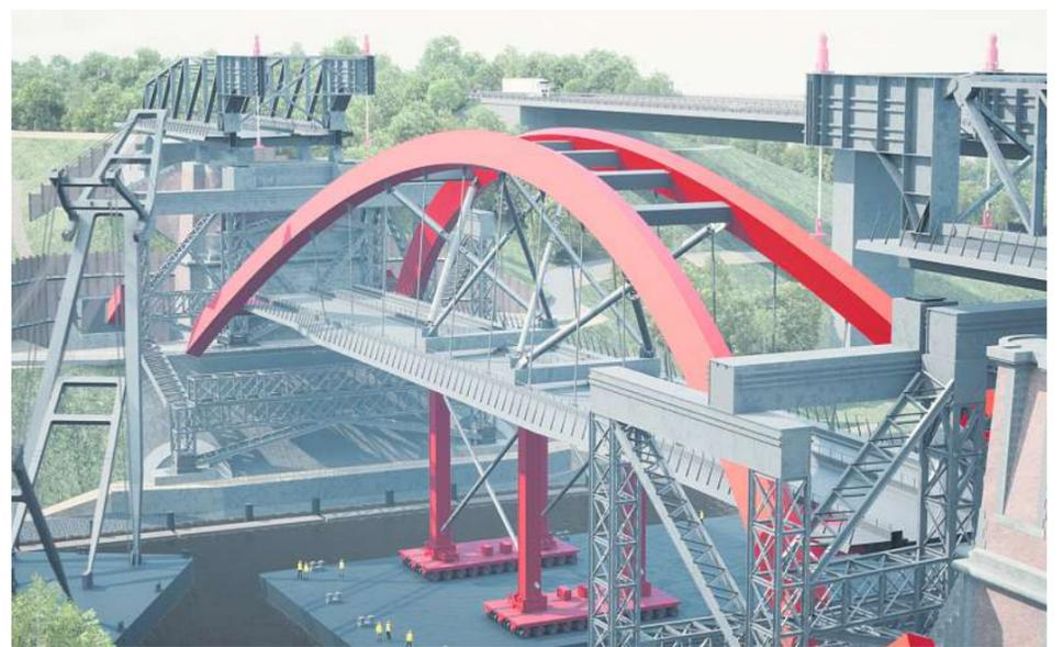
Wie in dieser Grafik dargestellt, wird das Mittelteil des Brücken-Neubaus auf einem Ponton über den Kanal bis zur Baustelle gehoben und dort in die Lücke des Neubaus gehoben. VISUALISIERUNG: WNA NOK
